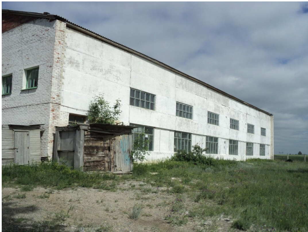
Фото 2.36. Здание очистных сооружений (с. Коелга).
