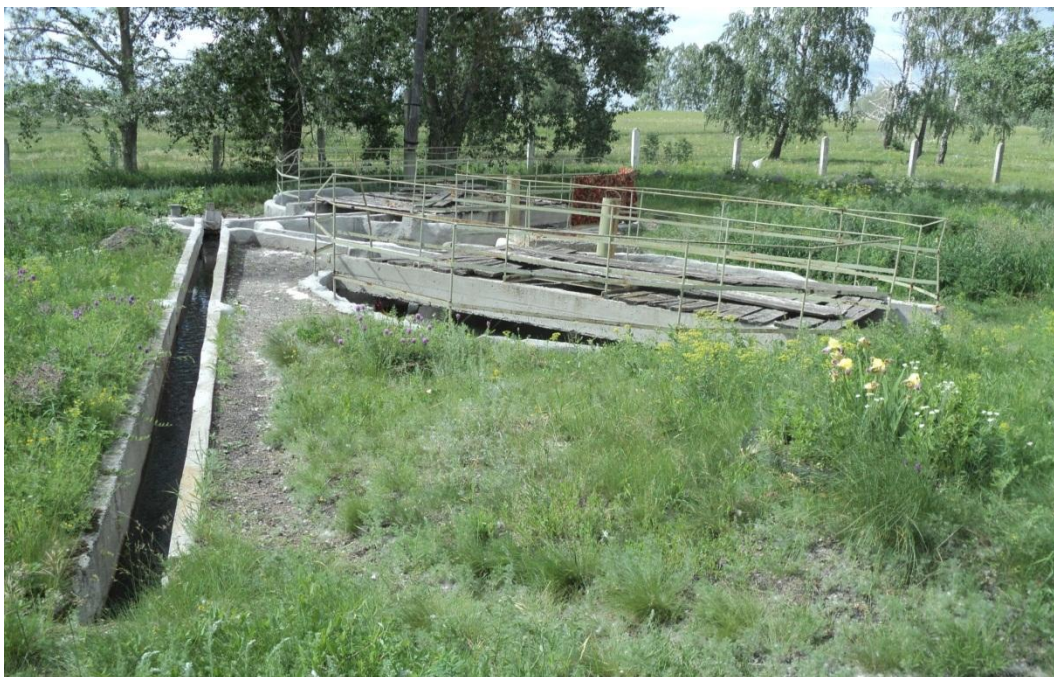
Фото 2.39. Отстойники (очистные сооружения с.Коелга)
