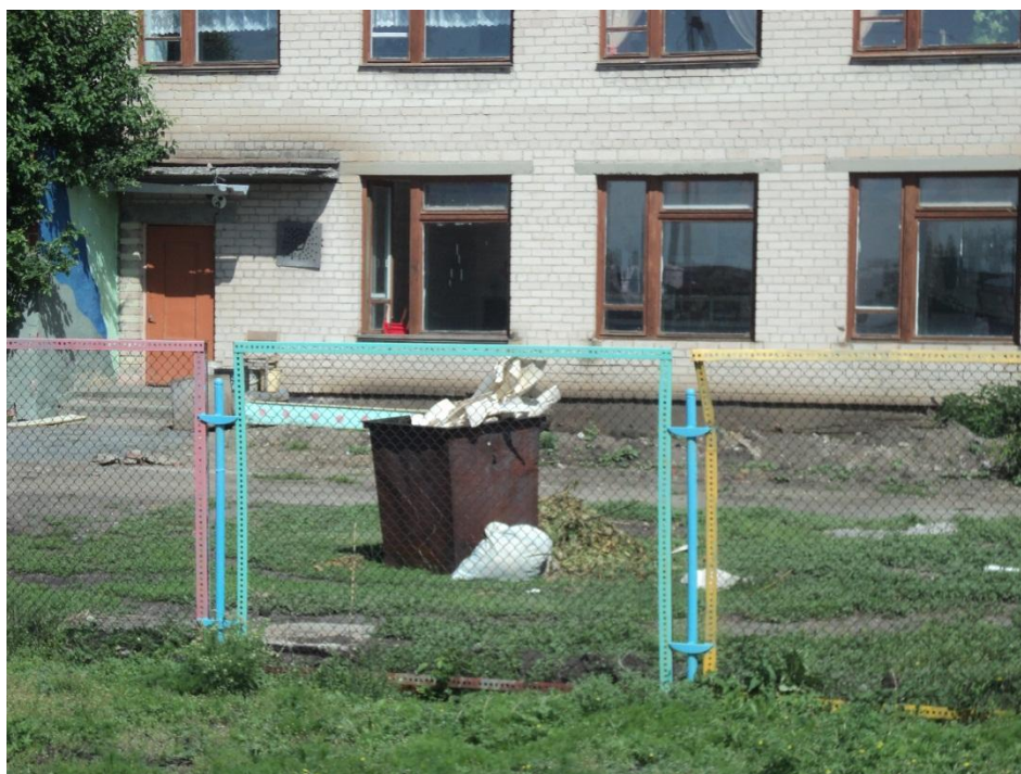
Фото 2.2. Детский сад «Одуванчик» по ул. Октябрьская, с. Еткуль. Контейнерная площадка не оборудована, контейнер переполнен.
