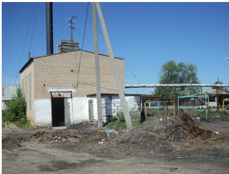
Фото 2.18. Шлак отвал и очаговый навал мусора возле котельной детского сада «Одуванчик» (с. Еткуль)
